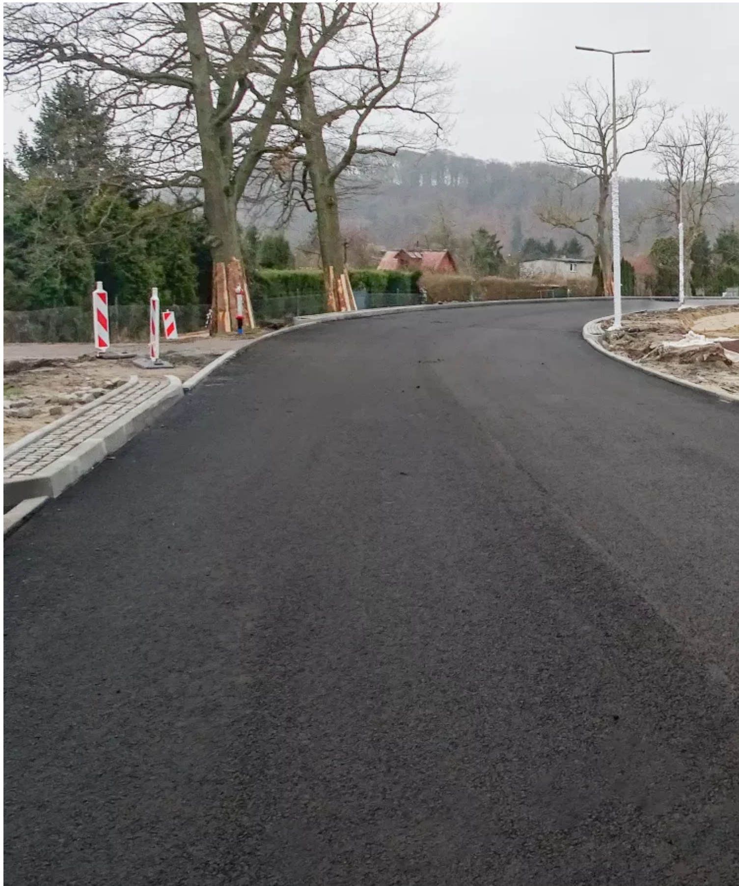
Droga i kanalizacja deszczowa na s?abym gruncie etap II.
