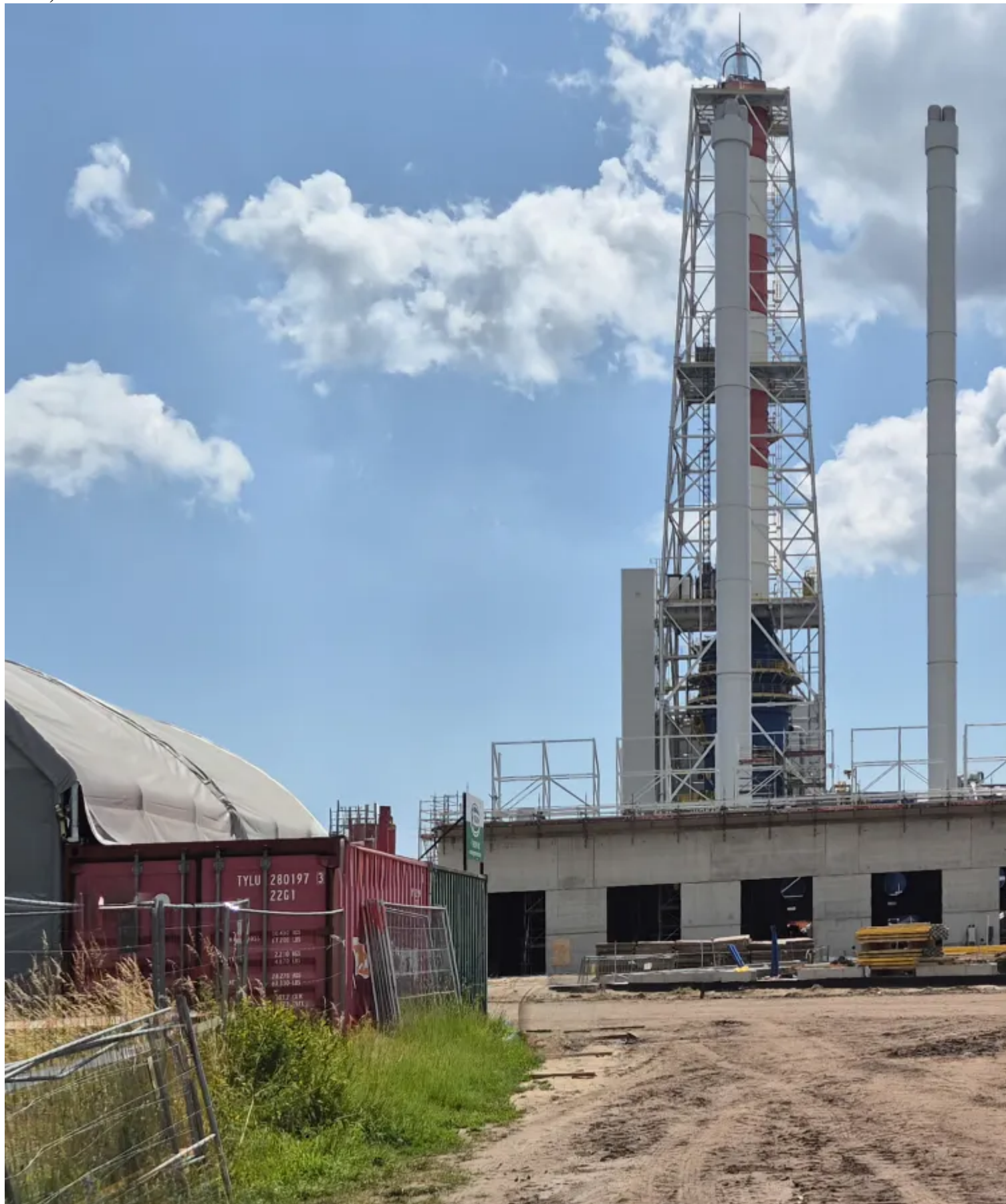
Leca® KERAMZYT zastosowano do wykonania stropodachu
