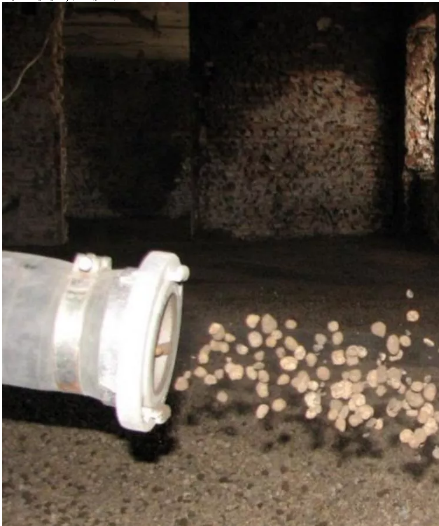
Leca® KERAMZYT zastosowano do wype?nienia stropu Kleina .
