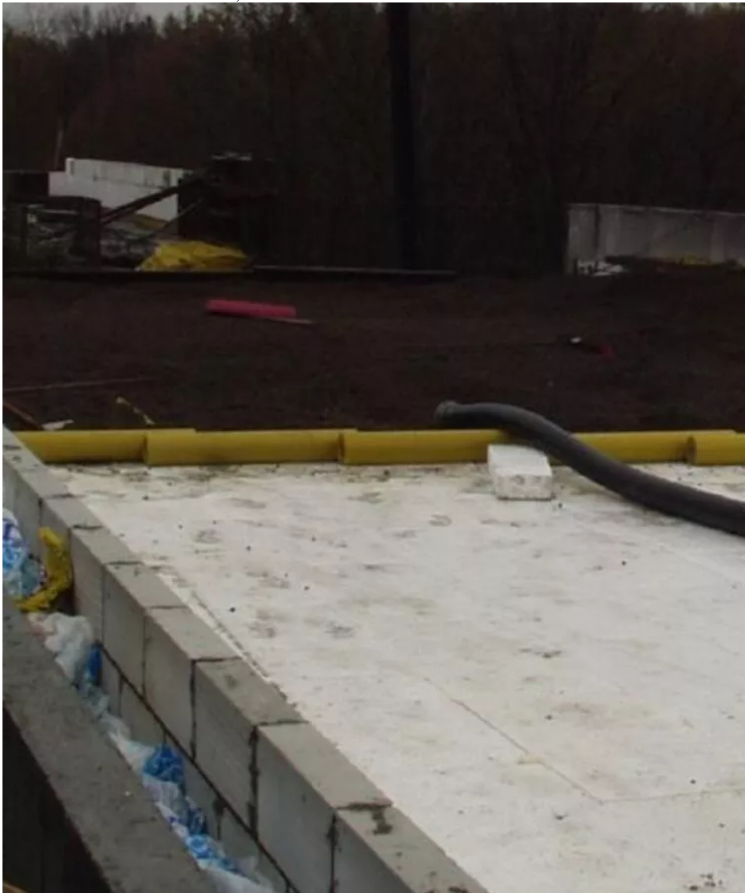
W obiekcie zastosowano Leca® KERAMZYT do izolacji stropodachu.
