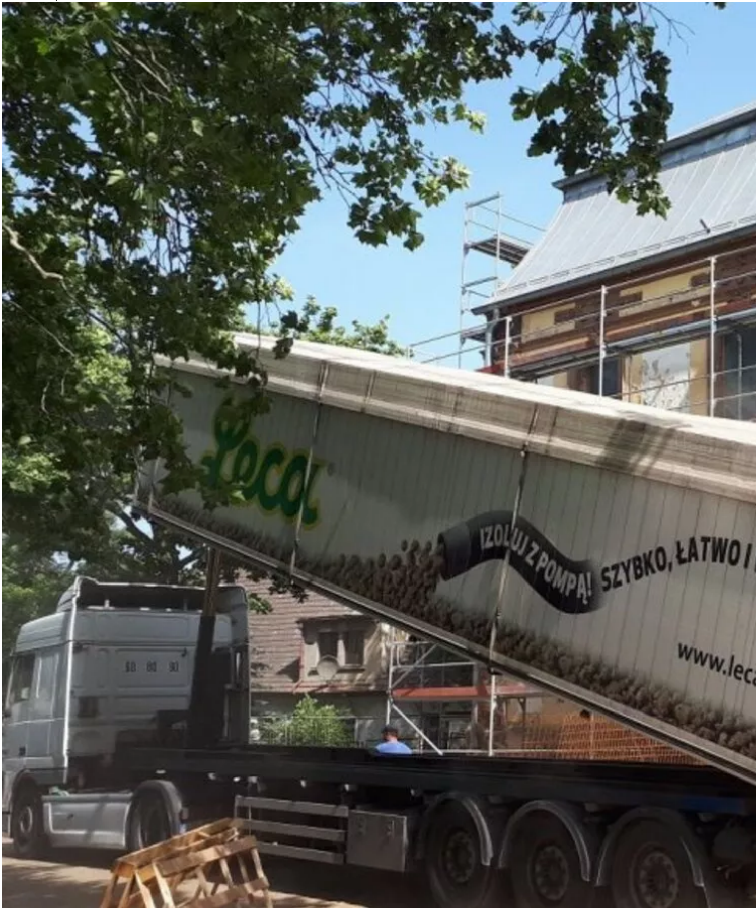
Leca KERAMZYT ułożono na stropach i podłogach podłóg na gruncie.
