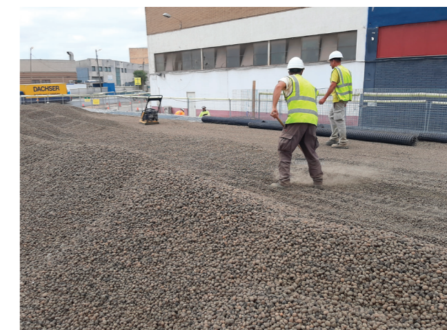
Ręczne rozprowadzanie materiału w pobliżu murów oporowych
