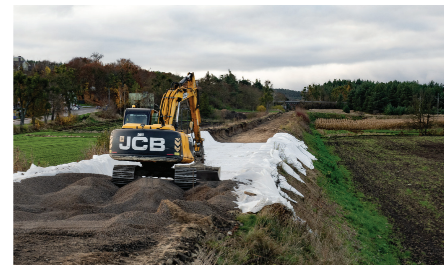
Szybka i łatwa realizacja wymagająca użycia jedynie standardowego sprzętu do robót ziemnych.
