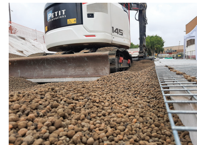
Zagęszczanie materiału przy użyciu podstawowego sprzętu budowlanego – gąsienic koparki
