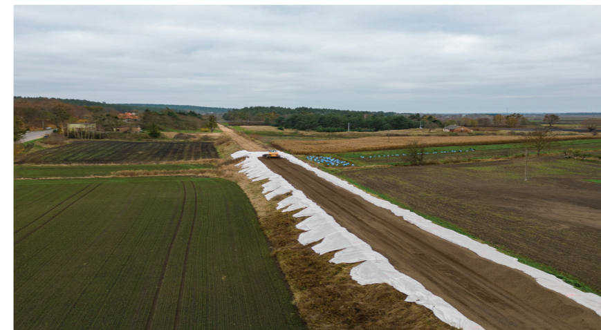
Dla zapewnienia stateczności nasypu zaprojektowano odciążenie podłoża używając lekkiego kruszywa Leca®.
