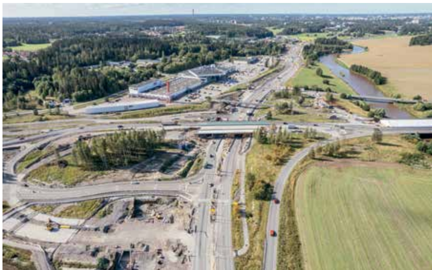
Budowa tego projektu o wartości 35 milionów euro rozpoczęła się w sierpniu 2020 roku..
