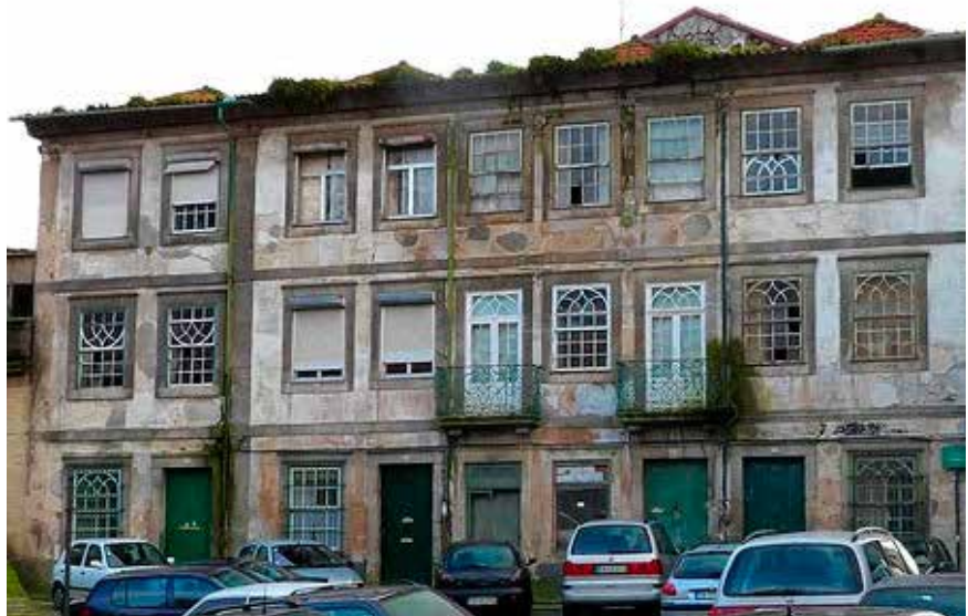
Prace renowacyjne rozpoczęły się w 2019 roku, zachowując oryginalne cechy budynku. (Zdjęcie: @Teodósio Dias 2013)
