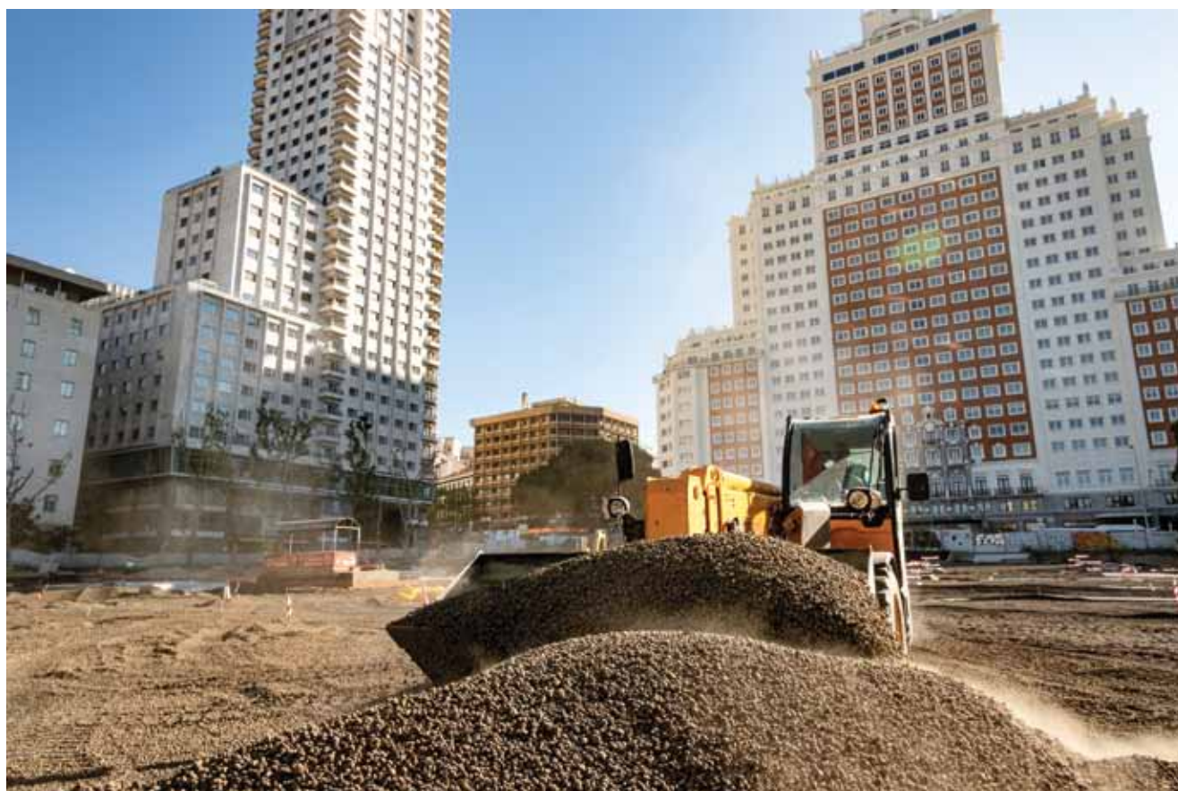
Rozkładanie i zagęszczanie Leca® KERAMZYTU na 10 000 m 2 placu
