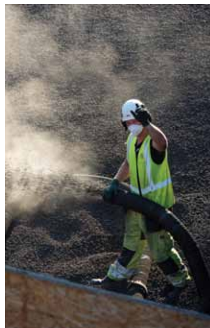
Lekkie wypełnienia drenują, izolują i zmniejszają obciążenie ścian
