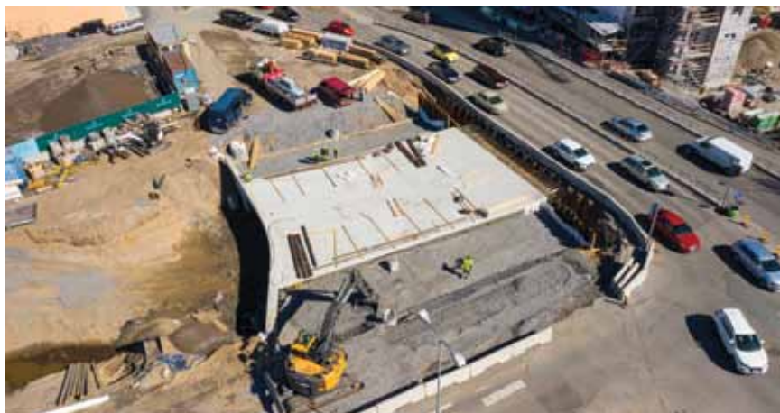
Na placu budowy przygotowano miejsce pośredniego składowania materiału
