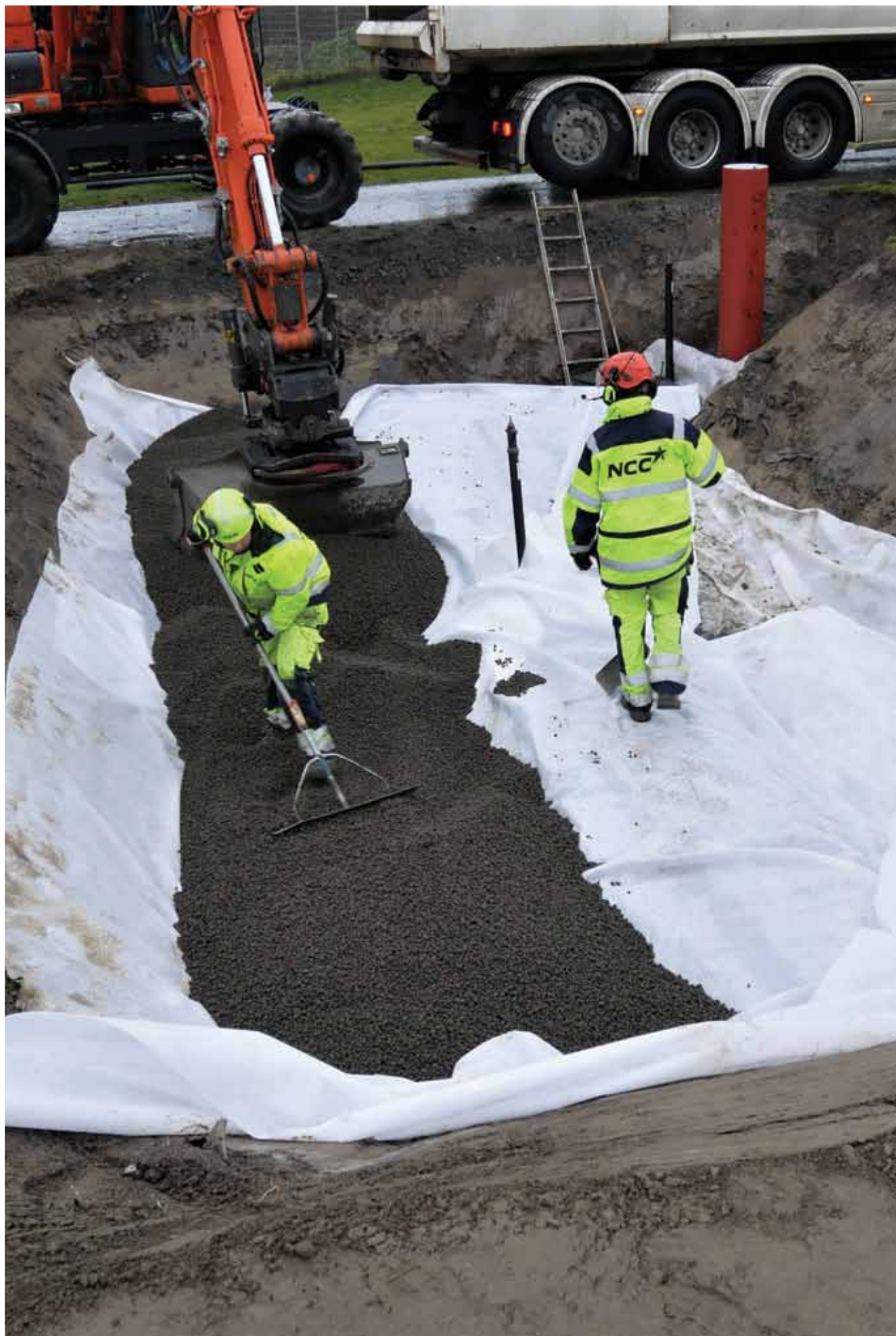
W czasie realizacji prac przeprowadzono szereg testów skuteczności odwodnienia terenu
