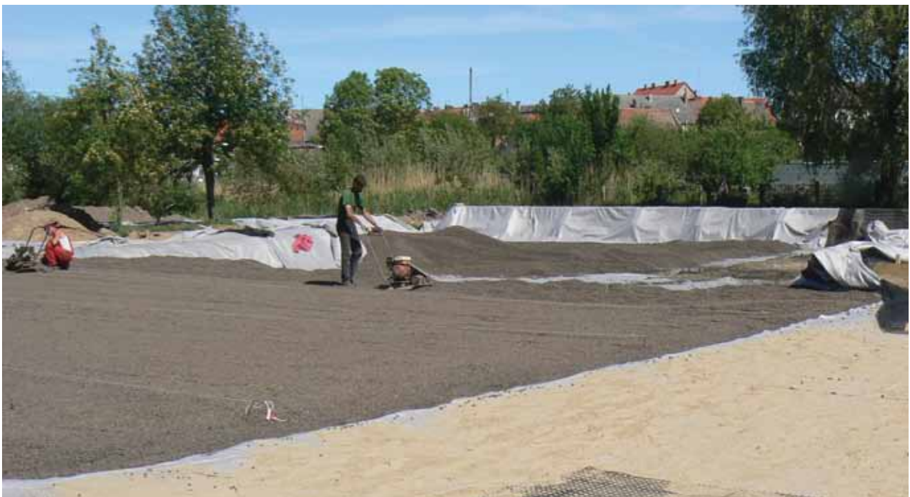
Układanie pierwszej warstwy Leca® KERAMZYTU
