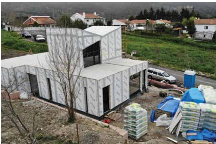
Do izolacji podłóg użyto sześćset worków Leca® Dry
