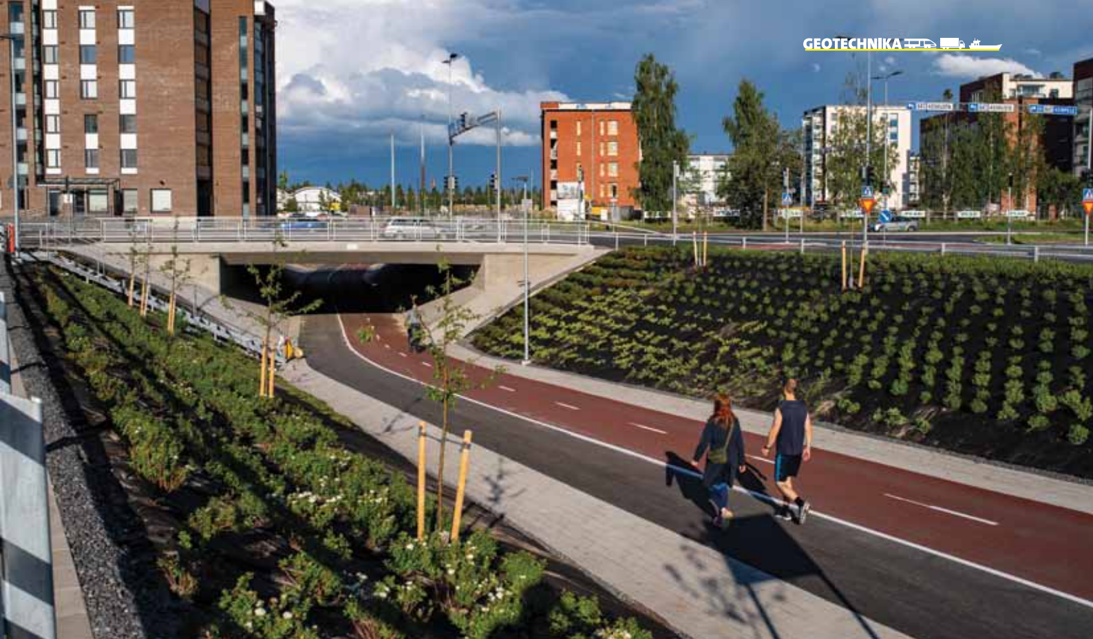
Przebieg podziemny Rautionpolku został ukończony w listopadzie 2019 roku
