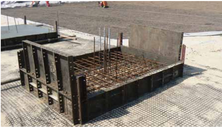
Fundamenty na lekkim kruszywie
