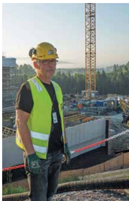
Kierownik budowy Svein Harald Øyhus w porannym słońcu czeka na pierwszą dostawę keramzytu
