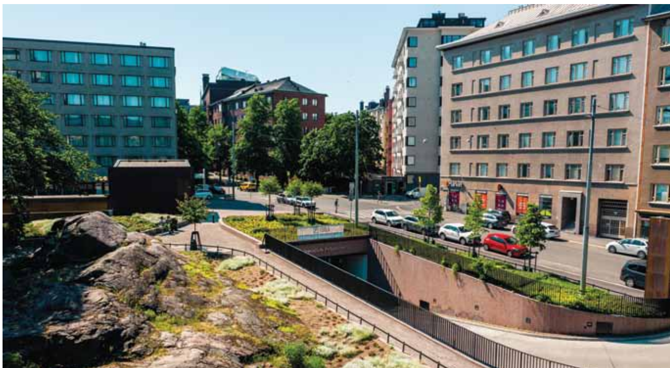
Nowy park Kivelänkatu został zbudowany nad garażem podziemnym i na przyległym terenie.
