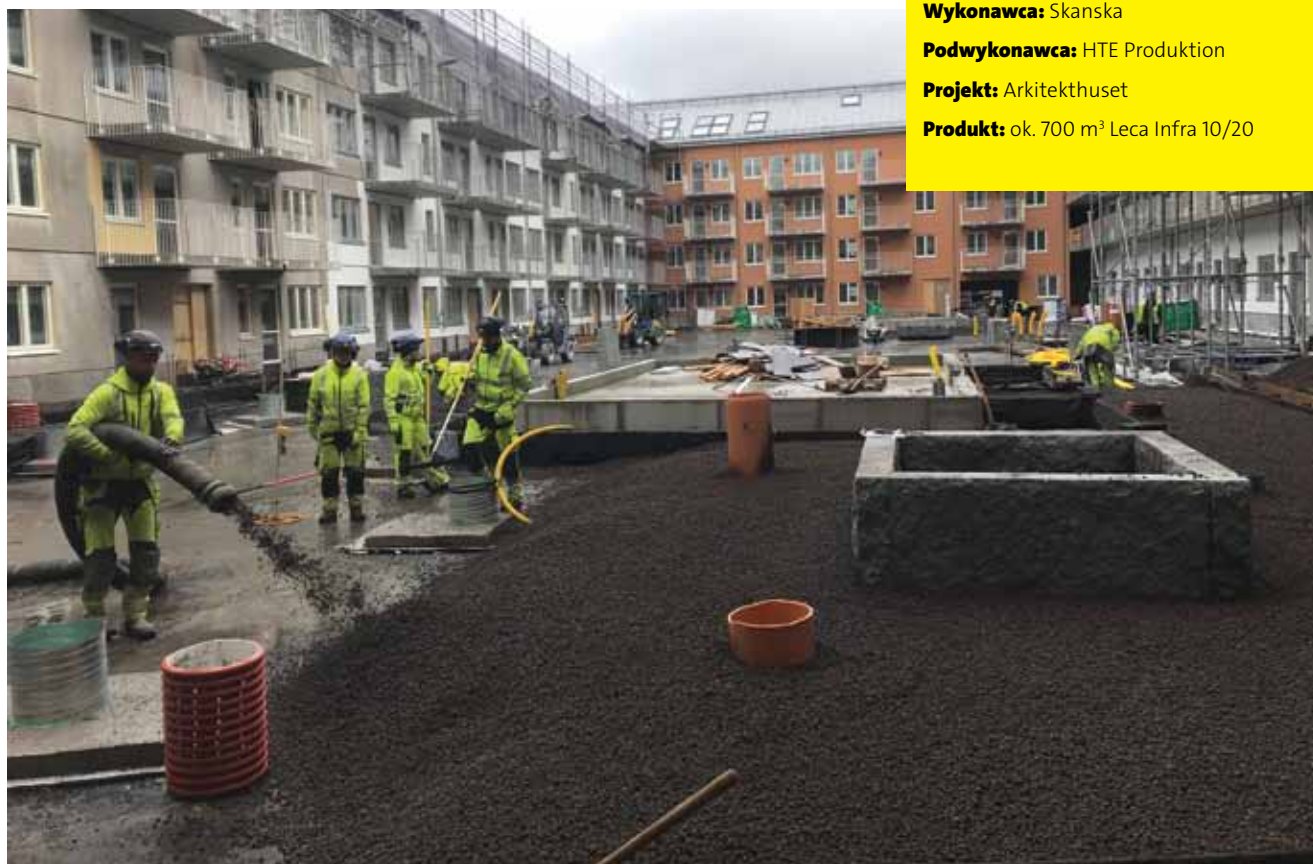
Pneumatyczna dostawa do miejsca ułożenia pozwoliła podwykonawcy dotrzymać harmonogramu prac
