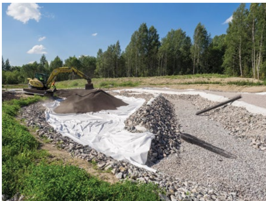
Druga sekcja zawiera kruszone Leca® (wielkość ziarna 3-8 mm) produkowane w fabryce Kuusankoski przez Leca Finland.
