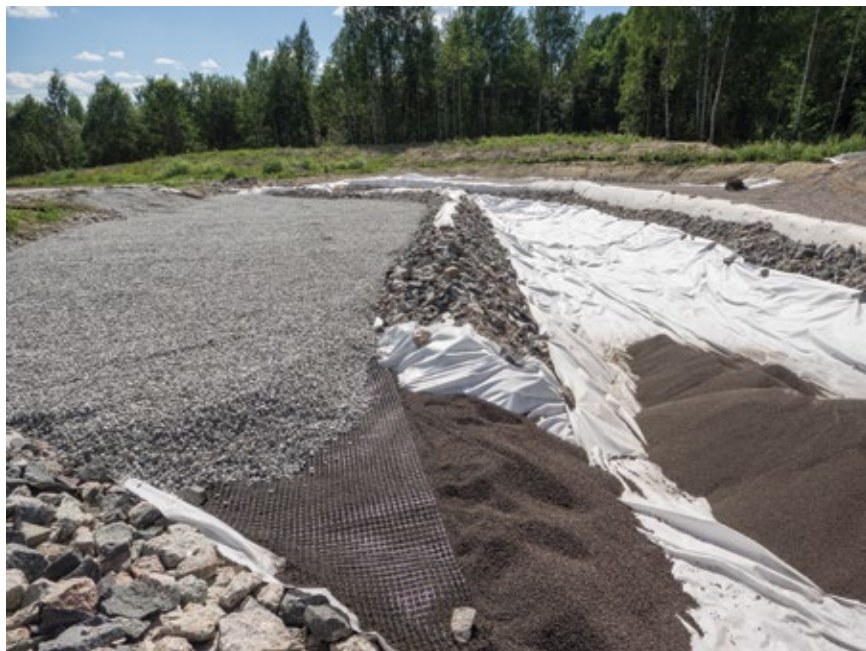
Jedna sekcja zawiera bardziej drobnoziarnisty materiał filtracyjny Filtralite P, który jest produkowany w fabryce Leca® w Raelingen w Norwegii.
