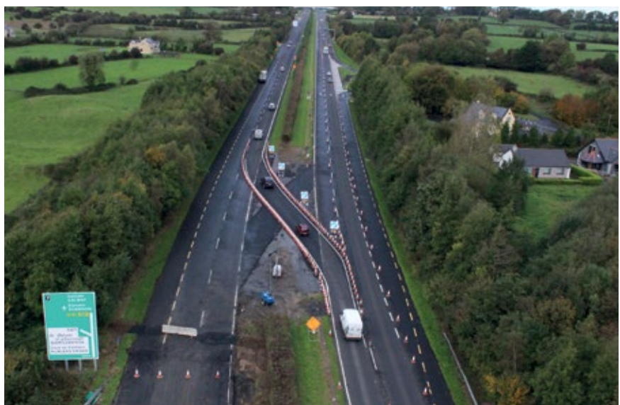
Leca® dostarczył podstawowego materiału do przebudowy istniejącej drogi dwujezdniowej o długości 1,6 km.
