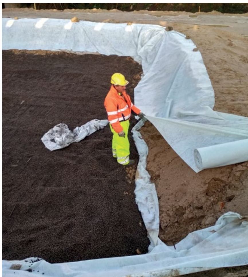
Układanie geowłókniny polipropylenowej (250 gr/m 2 ).
