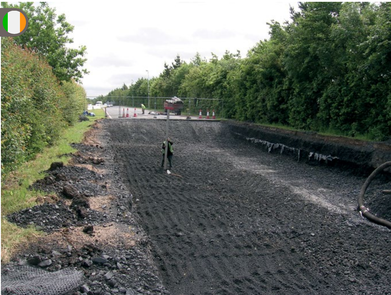
Leca® zastępuje ciężkie materiały do budowy dróg.
