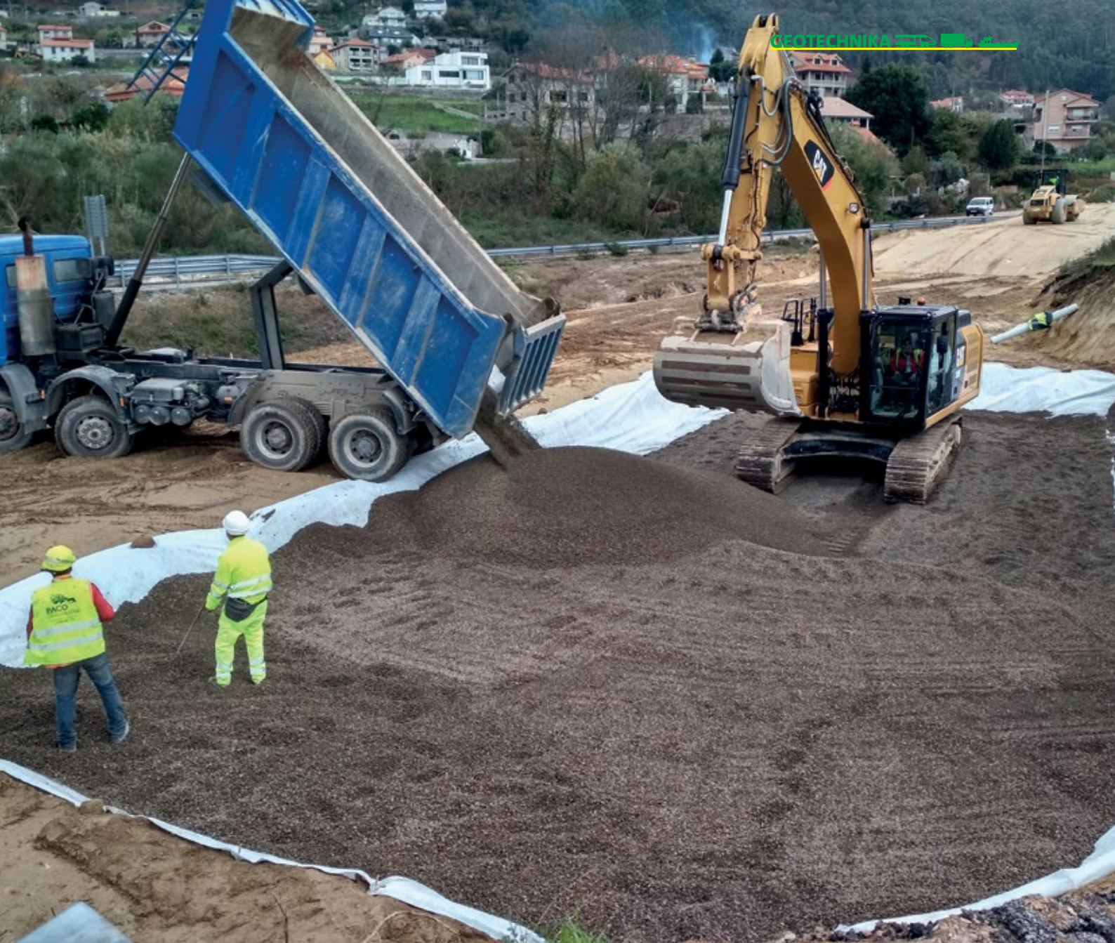
Układanie Arlita® w nasypie.
