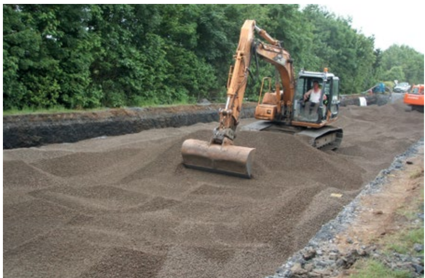
Właściwości wytrzymałościowe i zagęszczalność Leca® umożliwiły układanie ciężkim sprzętem.
