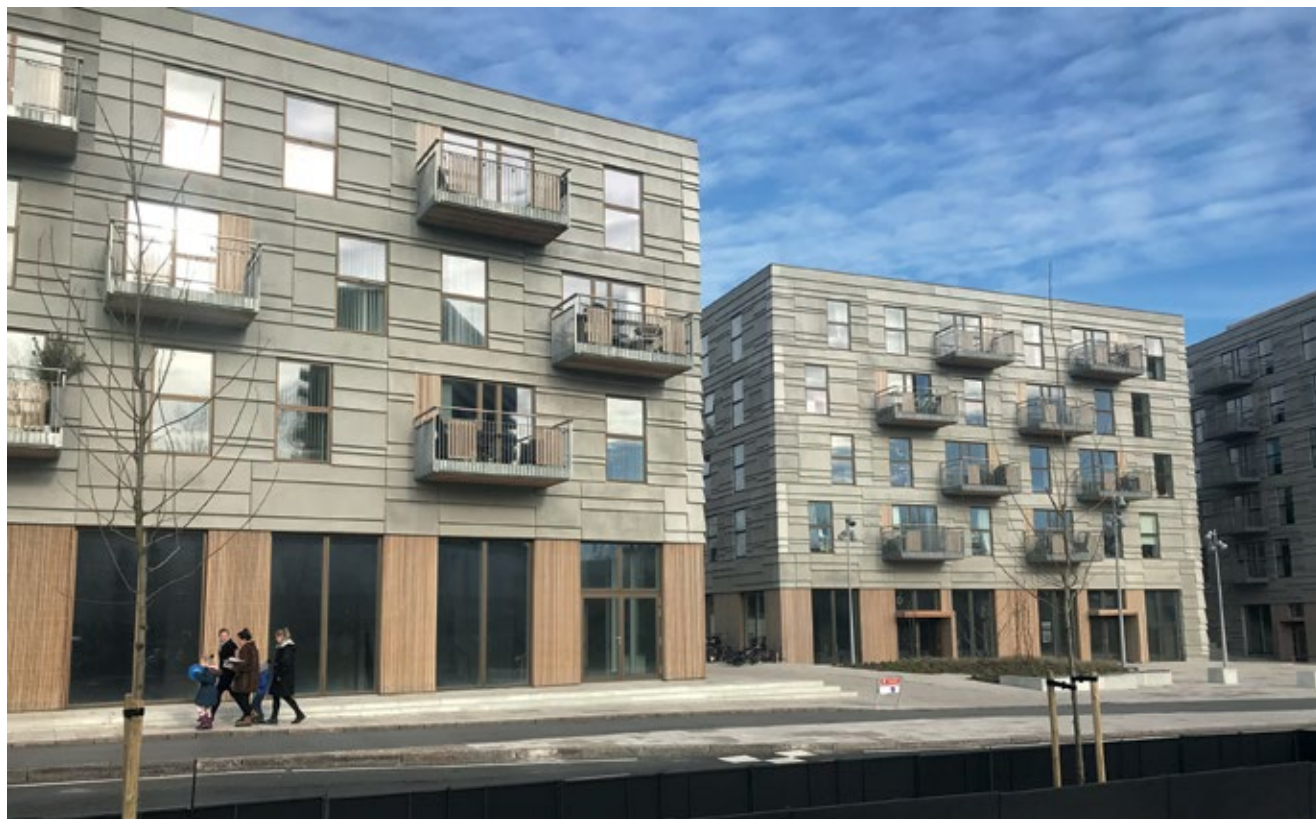
Leca® był zastosowany do drenaży piwnicy i wypełnienia pod dach zielony nad garażami
