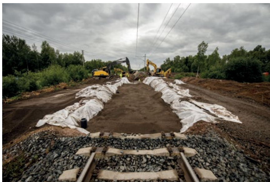
Szlak kolejowy między Kokemäki a Rauma w Finlandii został naprawiony przy użyciu wypełnienia lekkim kruszywem Leca®.
