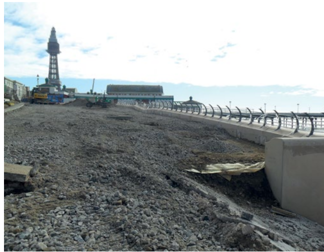
Keramzyt Leca® jest o 66% lżejszy od innych kruszyw tradycyjnych i znacznie bardziej optymalny w wypełnieniach.
