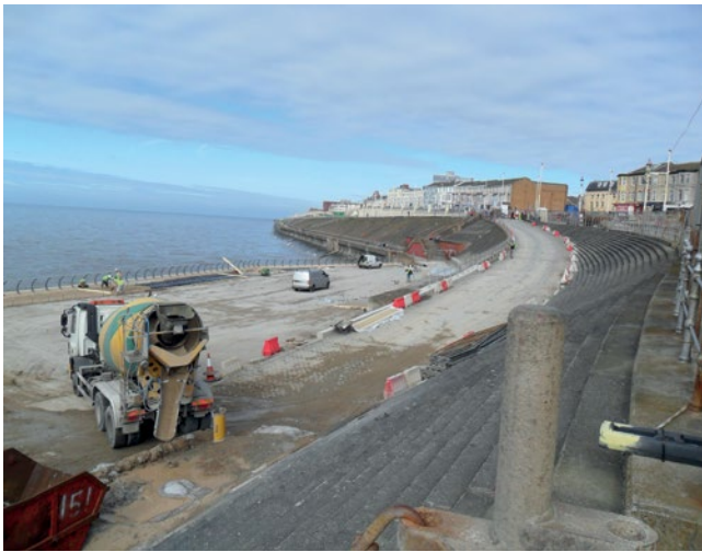
4 000 m 3 keramzytu Leca® zostało wykorzystane do wypełnienia pustki między istniejącym nabrzeżem a nową ścianą chroniącą przed falami.
