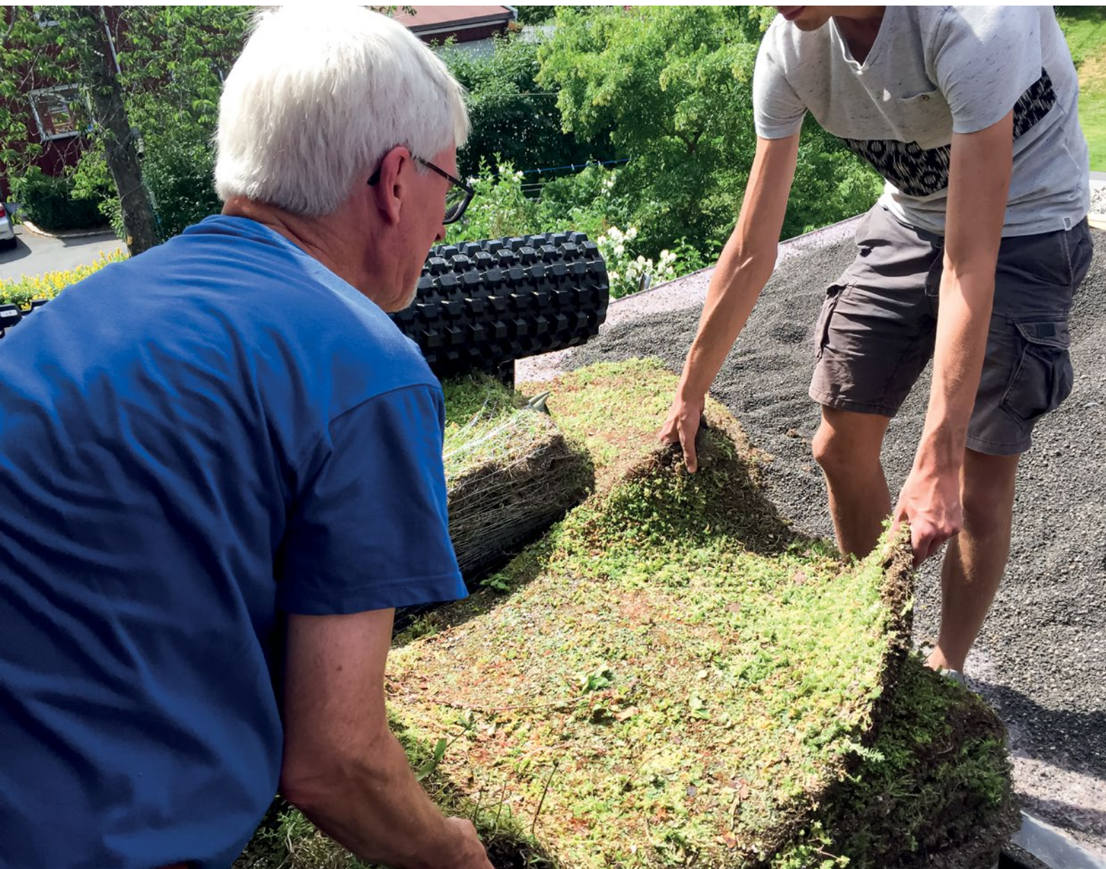
Kruszony Leca® keramzyt 0–6 mm został wykorzystany do maksymalizacji zatrzymywania wody, gdy Bent C. Braskerud instalował zielony dach na swoim domu w Oslo.
