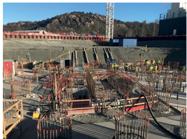
Kruszywo Leca® dostarczane jest ciężarówką do centralnej części fundamentów wieżowca
