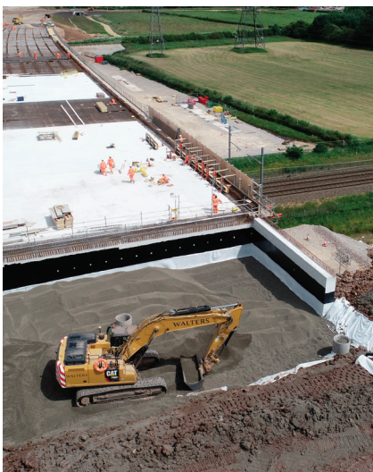
Wytrzymałe i lekkie Leca® KERAMZYT zapewniły spełnienie kluczowych wymagań na trudnych warunkach gruntowych
