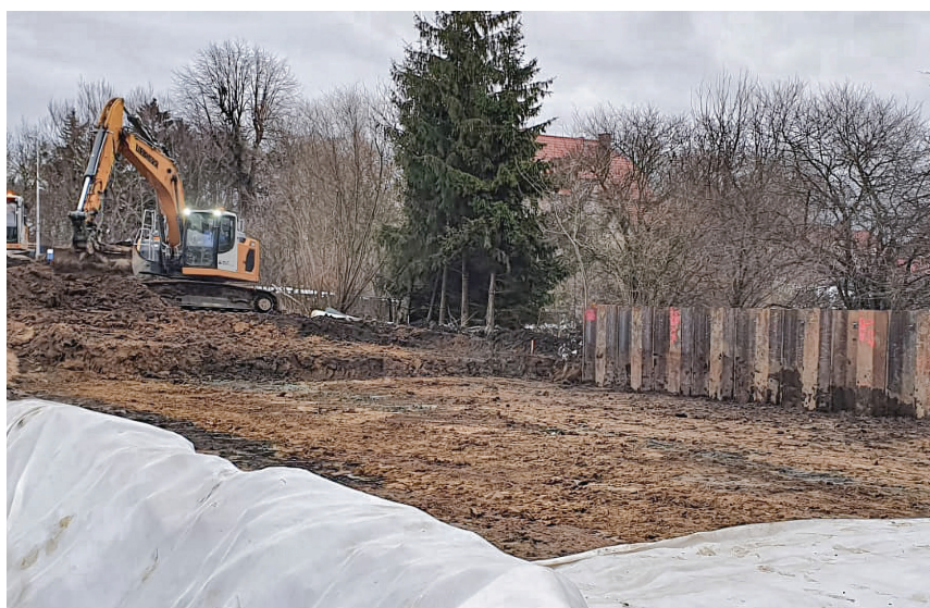
Wykonano zabezpieczenie korony torowiska w postaci konstrukcji oporowej wykonanej z odcinkowo kotwionej stalowej ścianki szczelnej.
