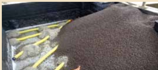
2. Zasypywanie rur drenażowych keramzytem. Wykonanie podbudowy z funkcją drenażową.
