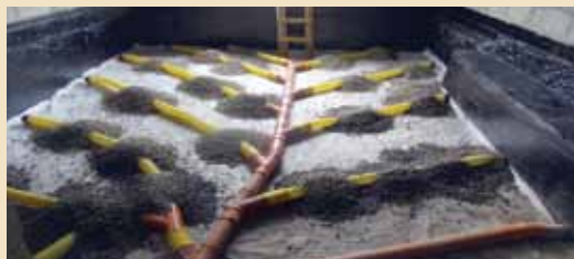
1. Ułożone rury drenażowe przygotowane do zasypania keramzytem.
