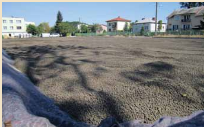
2. Warstwa drenażowa z keramzytu na geotekninie.
