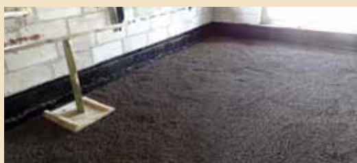
3. Zagęszczony keramzyt, podłoże gotowe do dalszych prac.
