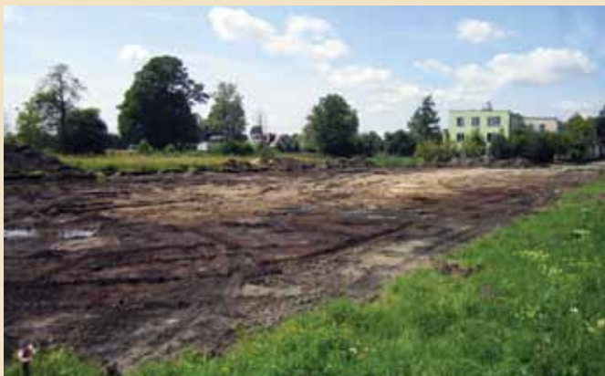
1. Usunięcie humusu i wykop.
