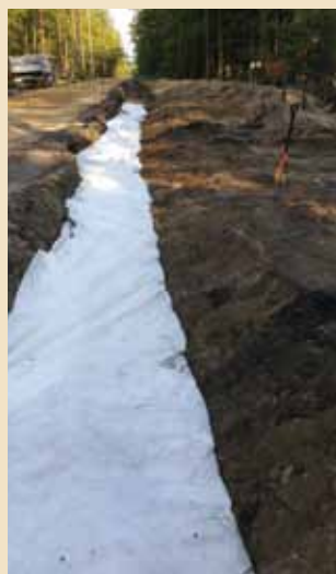
3. Dren zakryty geotkaniną - gotowy do zasypania gruntem.
