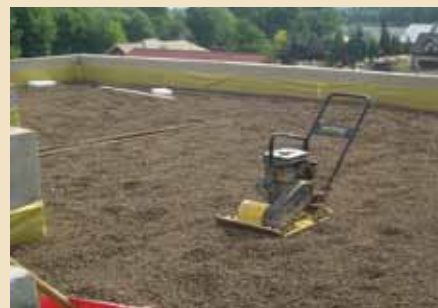
Zagęszczanie Leca® KERAMZYTU na stropodachu.
