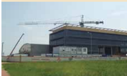
Budynek w końcowej fazie budowy.
