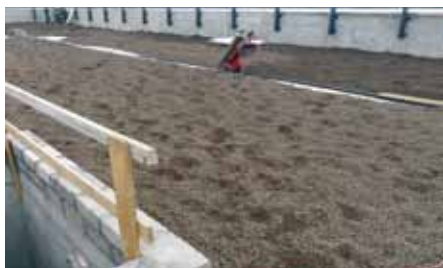
Układanie Leca® KERAMZYTU na stropodachu.
