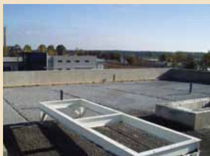
Warstwa spadkowa z keramzytem po ułożeniu szprycu.
