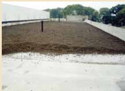
Układanie warstwy spadkowej.
