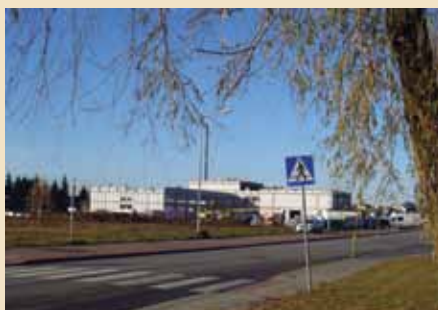
Budynek w trakcie robót.
