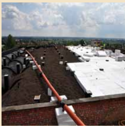
Układanie dodatkowej warstwy ocieplenia z EPS
