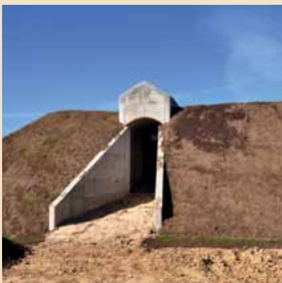
Budowla obsypana gruntem
