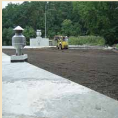
Układanie Leca® KERAMZYTU i warstwy betonu
