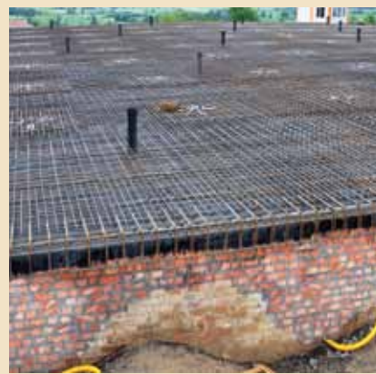
Zbrojenie dodatkowej płyty żelbe- towej
