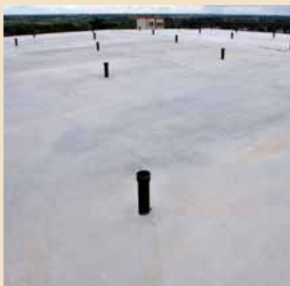
Gotowa płyty żelbetowa
