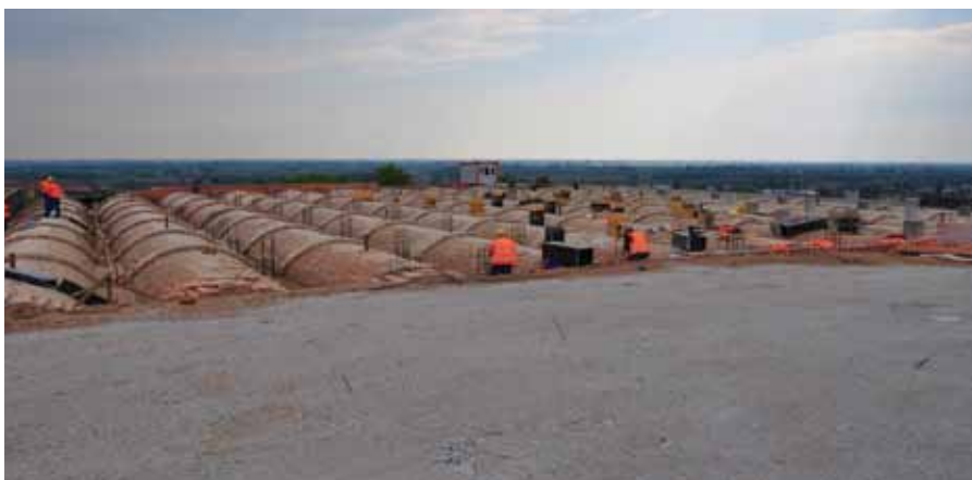
Sklepienia ceglane po usunięciu gruntu
