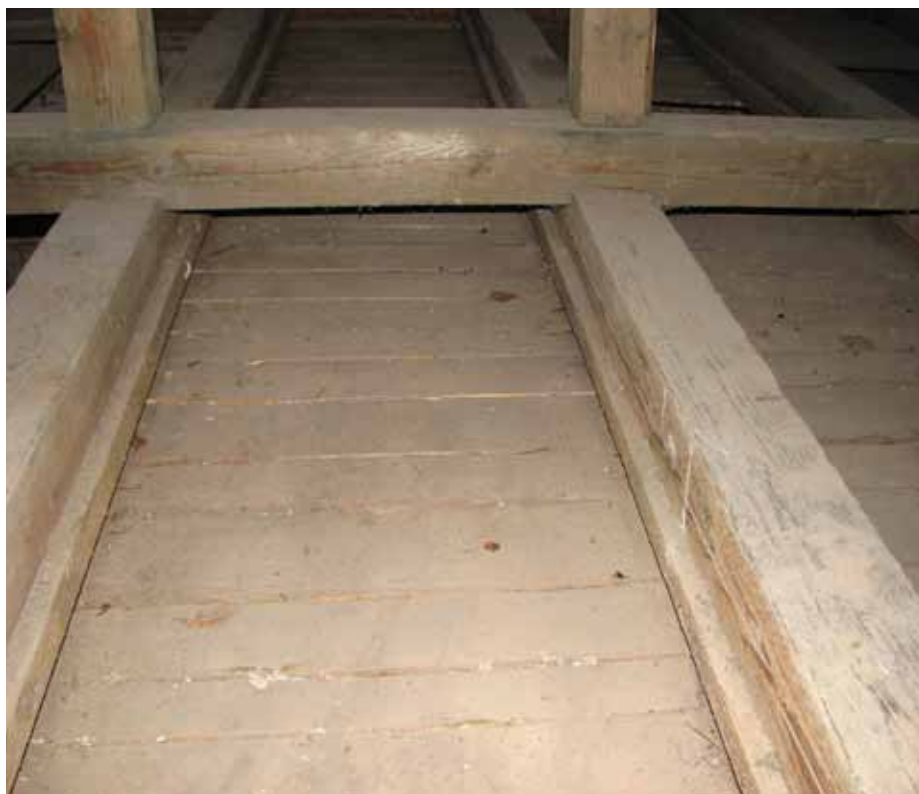
Typowy strop drewniany.
