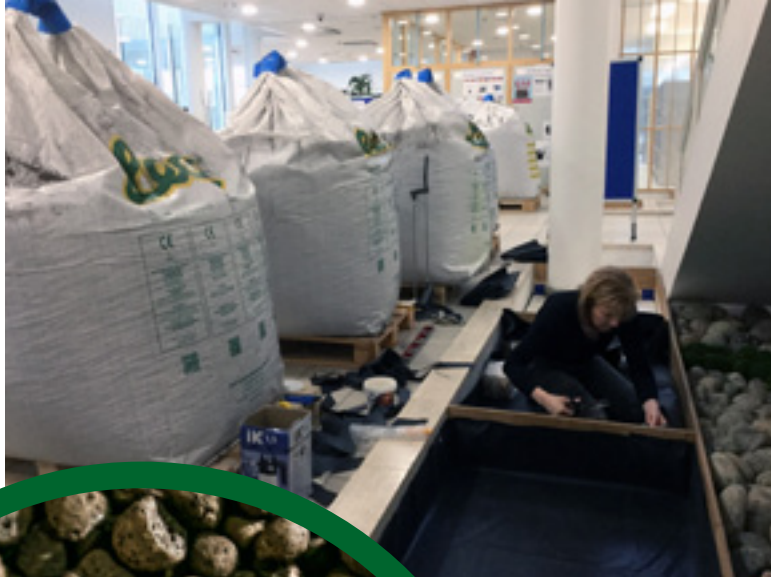
Arja Rantasalo sprawdza, czy pojemniki są szczelne, przed wypełnieniem ich keramzytem i wodą.
