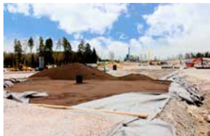
Zmniejszanie obciążeń konstrukcji dróg dojazdowych i instalacji wodociągowej.
