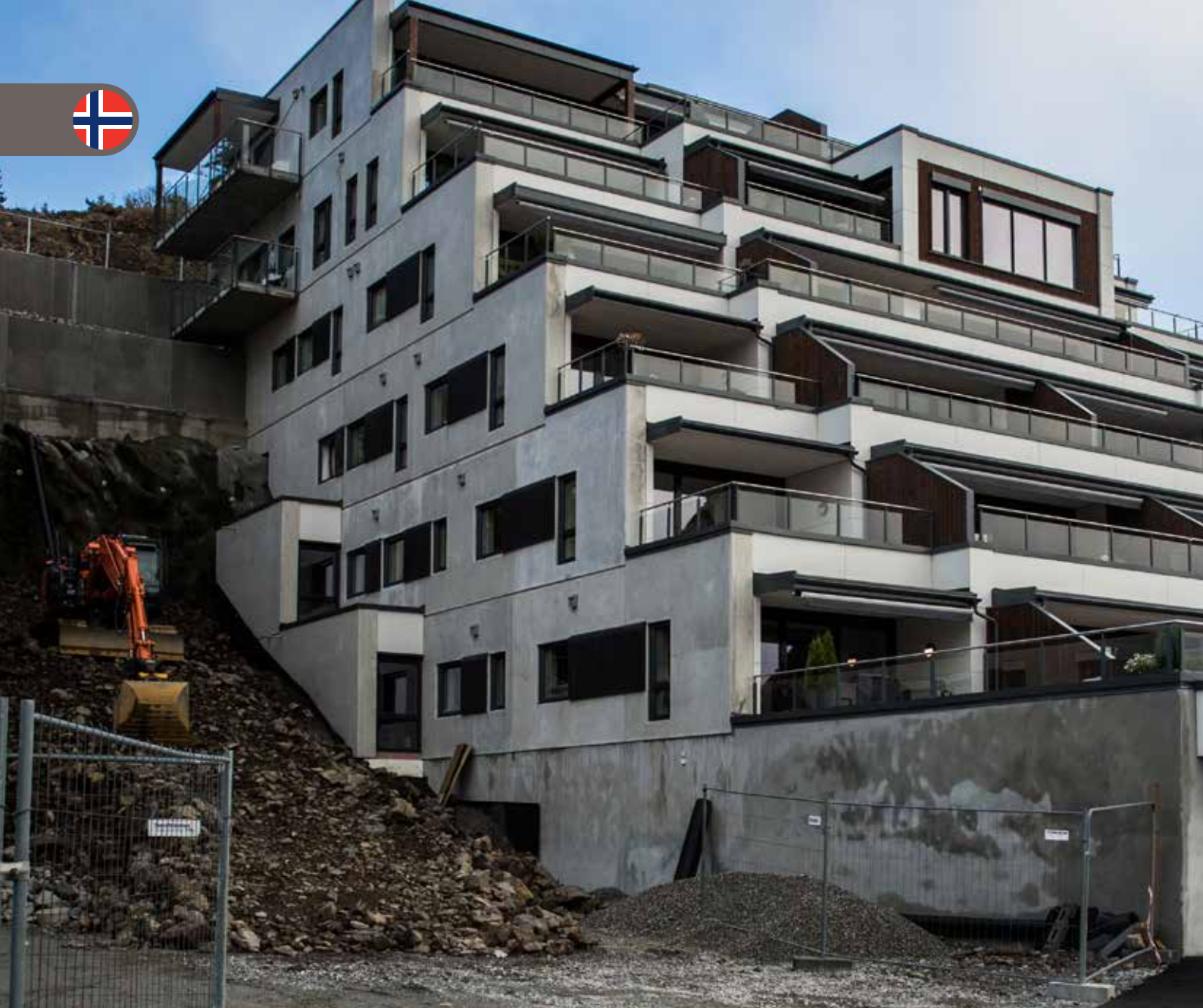
Jeden z trzech budynków wznoszonych w Hokksund przez firmę Betonmast
