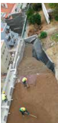
Przestrzeń pomiędzy nową ścianą a istniejącą skarpą wypełniono kruszywem Geo Leca.
