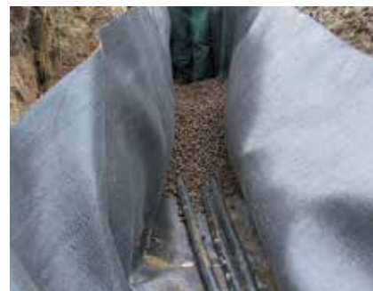
Kable elektryczne ułożono na geotekstynie wypełnionej keramzytem.
