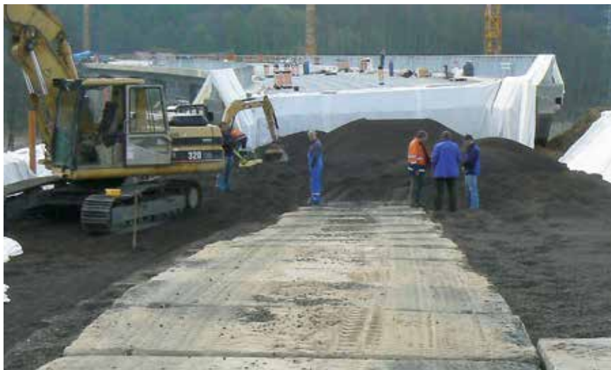
Najazdy na most wykonano na wypełnieniu z Leca KERAMZYTU.
