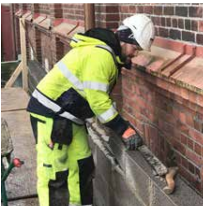
Wykonawcy mają pozytywne doświadczenia z budowy przegród przeciwogniowych, z zastosowaniem bloczków Leca.
