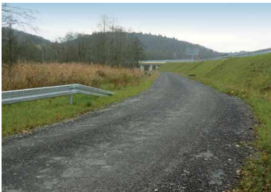
Konieczne było wykonanie kilku dróg serwisowych.
