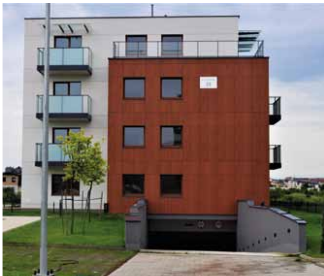
Wjazd do garażu
