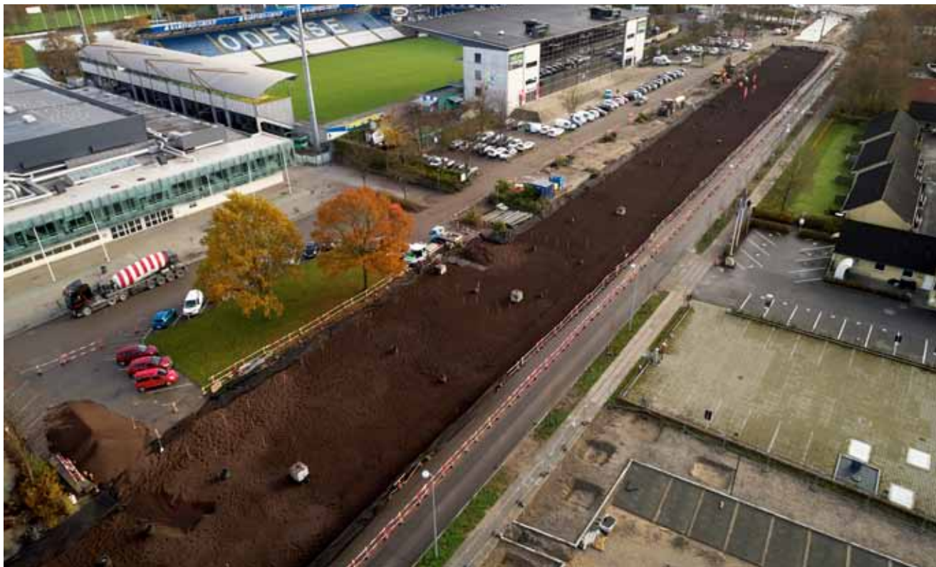
Na odcinku o długości 300 metrów wykorzystano 4200 m 3 Leca® KERAMZYTU
