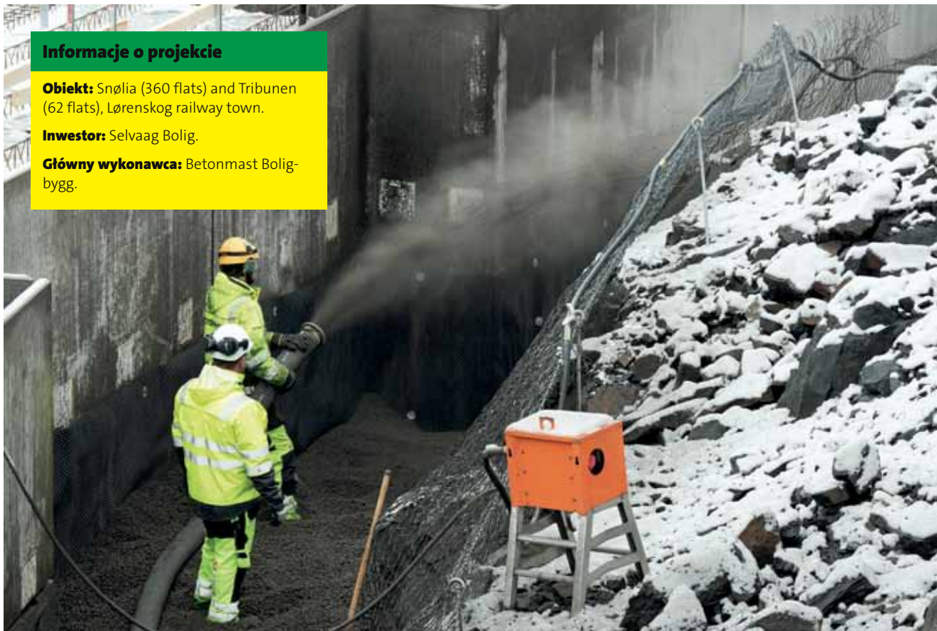
Andrzej Bojarczuk (z lewej) i Eirik Navelsaker sprawdzają czy zasypka nie wywiera zbyt dużego nacisku na ściany budynku.
