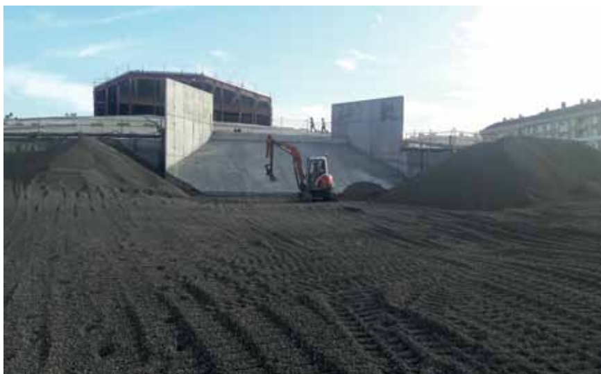
Zagęszczanie KERAMZYTU Arlita®, to działa.
