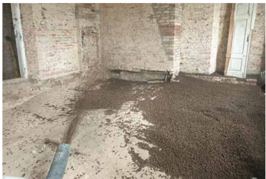
Układanie kruszywa przy użyciu pompy.
