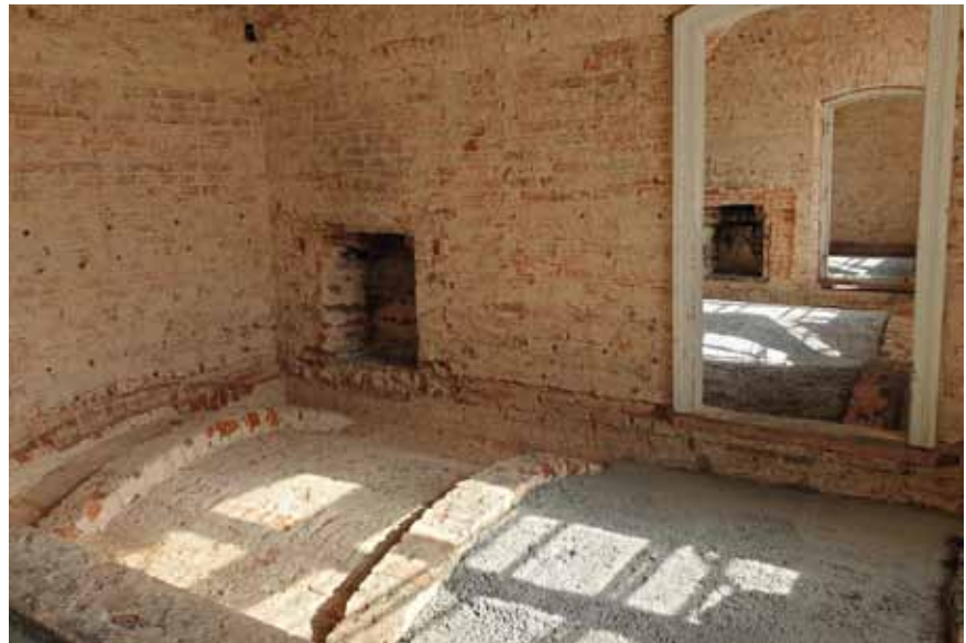
Jeden z remontowanych stropów.
