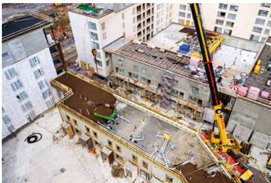
Na budynku wykonano dach zielony retencjonujący deszczówkę.
