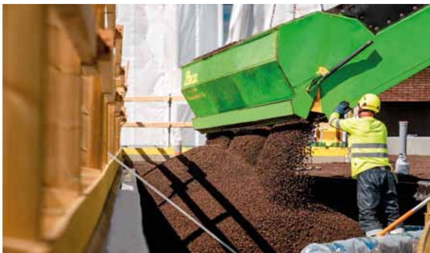
Leca®KERAMZYT podawano sprawnie na dach dźwigiem i specjalną skrzynią.
