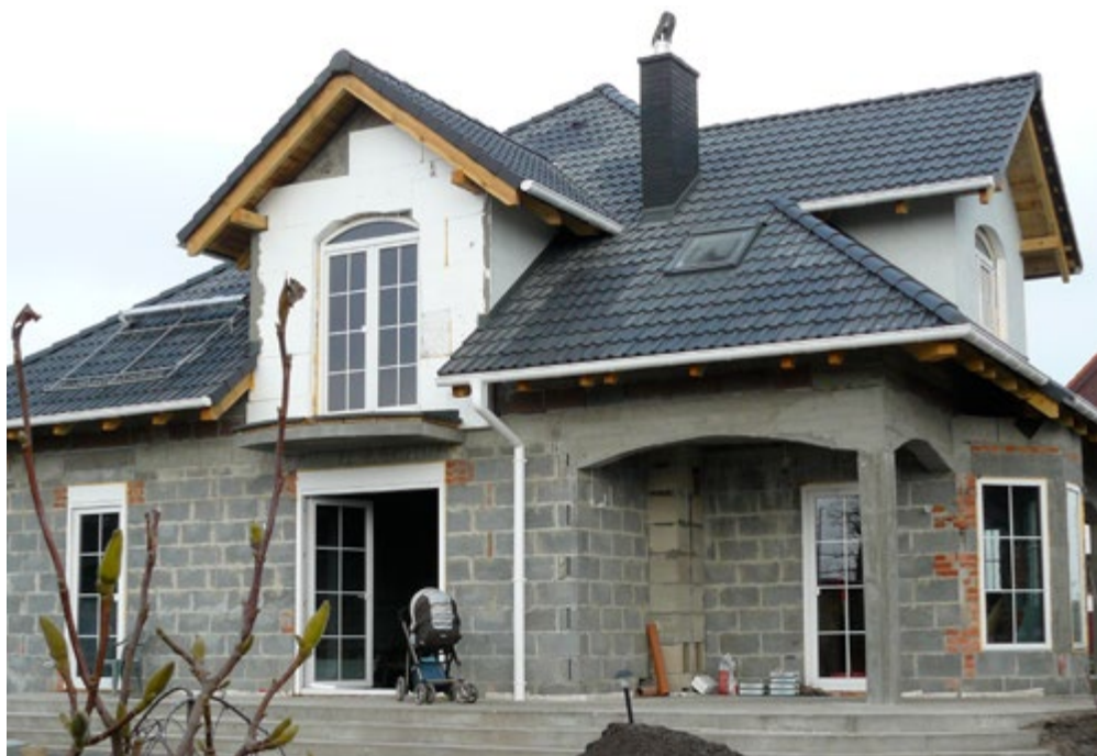
Stan surowy domu został wykonany niezwykle szybko.
