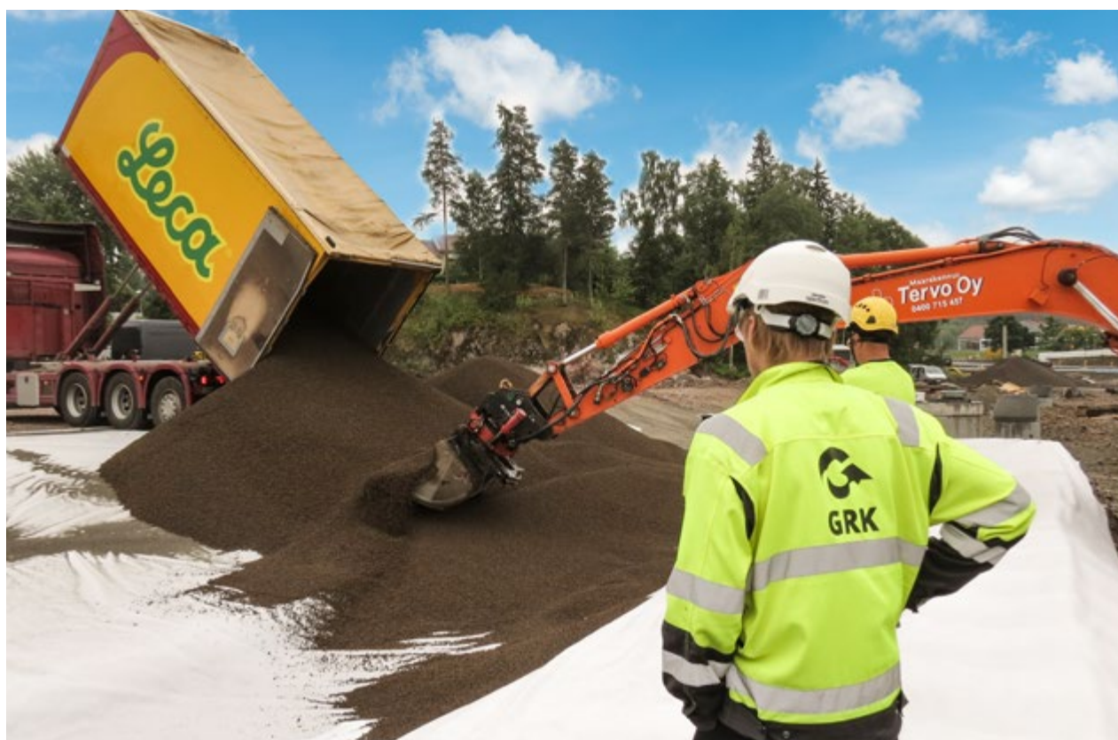
Keramzyt Leca jest dostarczany bezpośrednio na miejsce wbudowania .
