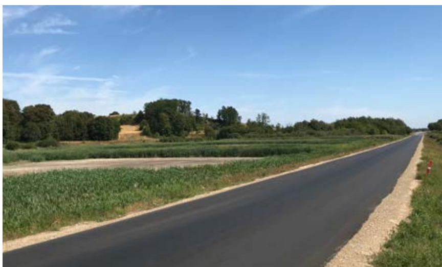
Ukończona droga biegnąca na podłożu torfowym.
