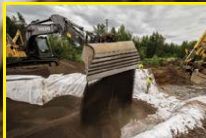
Na tej budowie ułożono łącznie ok. 2.500 m 3 keramzytu Leca.
