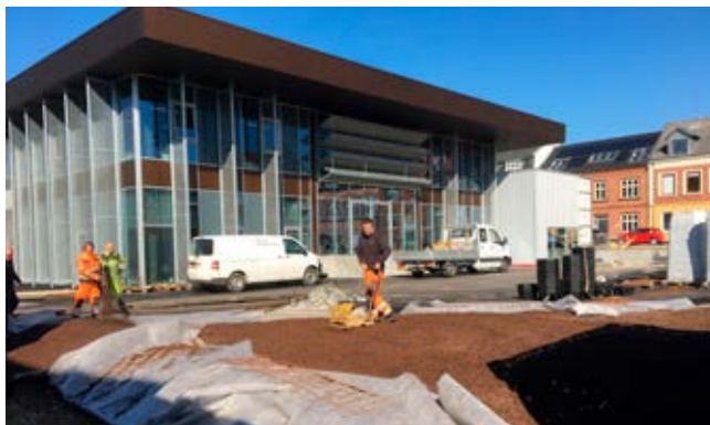
Do ukształtowania terenu zastosowano keramzyt Leca luzem, na którym ułożono keramzytobeton i nawierzchnię asfaltową.
