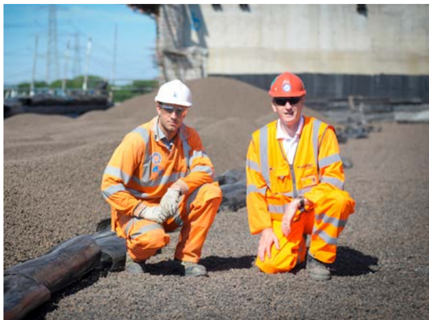
Na budowę dostarczono ciężarówkami samowyładowczymi łącznie 26.000 m 3 keramzytu Leca luzem.
