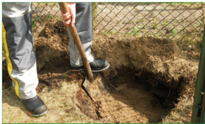
1. Wykopujemy dołek o głębokości 30-40 cm.
