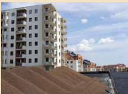
Leca Keramzyt dostarczono ciężarówkami bezpośrednio na dach garaży podziemnych.
