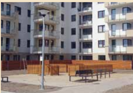
Dach gotowy do wykonania nasadzeń.
