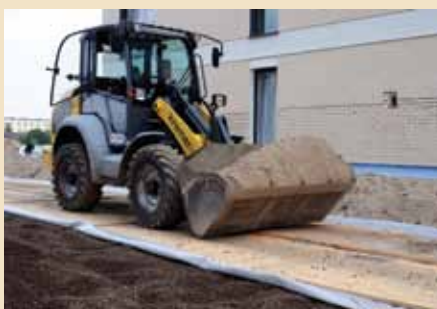
Sposób na zagęszczenie i transport po keramzycie.
