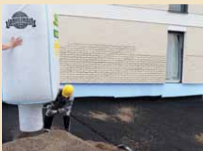
Transport i układanie keramzytu bezpośrednio z big-bagów.
